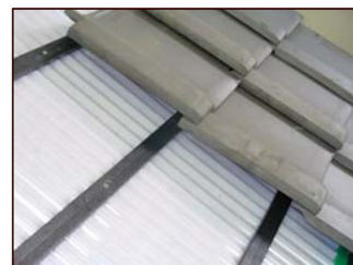
④瓦を施工
