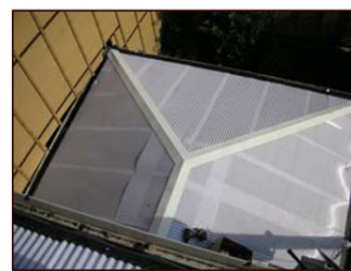
②ポリカアンダーウェーブを施工
