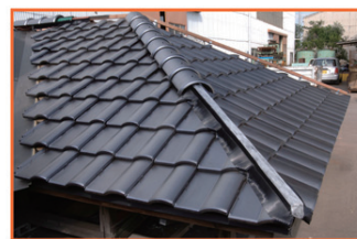
アルスカートを棟木に沿って貼り付けます。上部は防水プチルテープを貼り付けます
